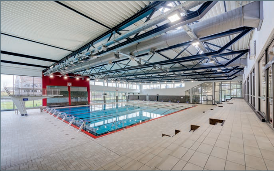
■ Beispielhaft für die Kategorie „Neubau an einem anderen Standort“: Das „Sportbad Thurmfeld“ in Essen als Ersatz für das „Hauptbad“, Foto: Pellikan, Ratingen (siehe AB 03/2016, Seite 129) ...
