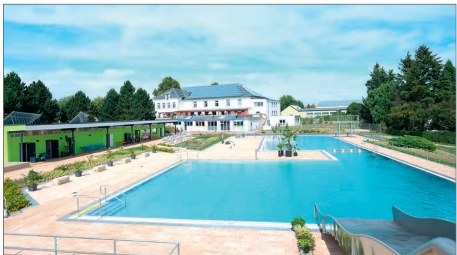
■ ... und die Generalsanierung im Freibad Leisnig: In einem Teil des früheren 50-m-Beckens wird die neue Technik untergebracht; Foto: Bauplanungsbüro Schroeder/architektur, Döbeln, (siehe AB 05/2016, Seite 266 ff.).
