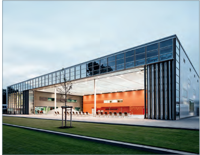
■ Südfassade geöffnet; Foto: Meike Hansen, Hamburg
